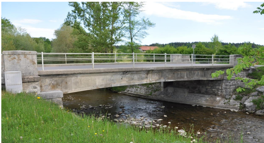
Vue depuis l'aval du pont existant
